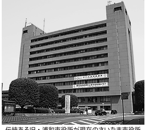
伝統ある旧・浦和市役所が現在のさいたま市役所
